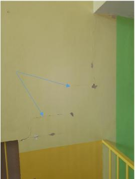
Ces fissures suivent les joints de maçonnerie ou les changements de matériaux (doublage-maçonnerie).
